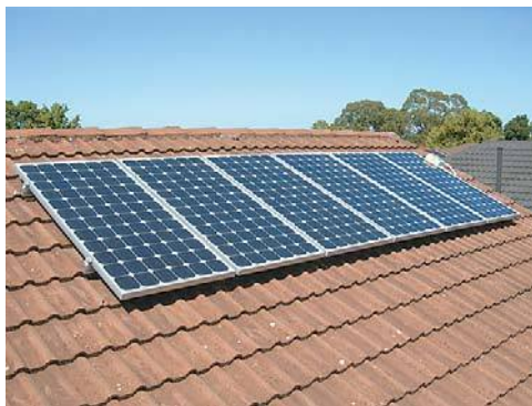
Рис. 51. Солнечная батарея, изготовленная с применением кристаллического кремния
