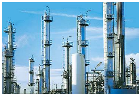
Рис. 34. Ректификационные колонны на нефтеперерабатывающем заводе
